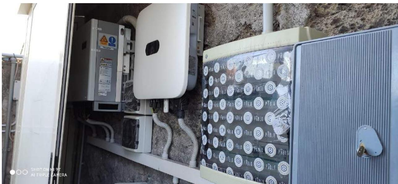
Fig.13: Particolare 1 cabina inverter a servizio dell'impianto fotovoltaico.
