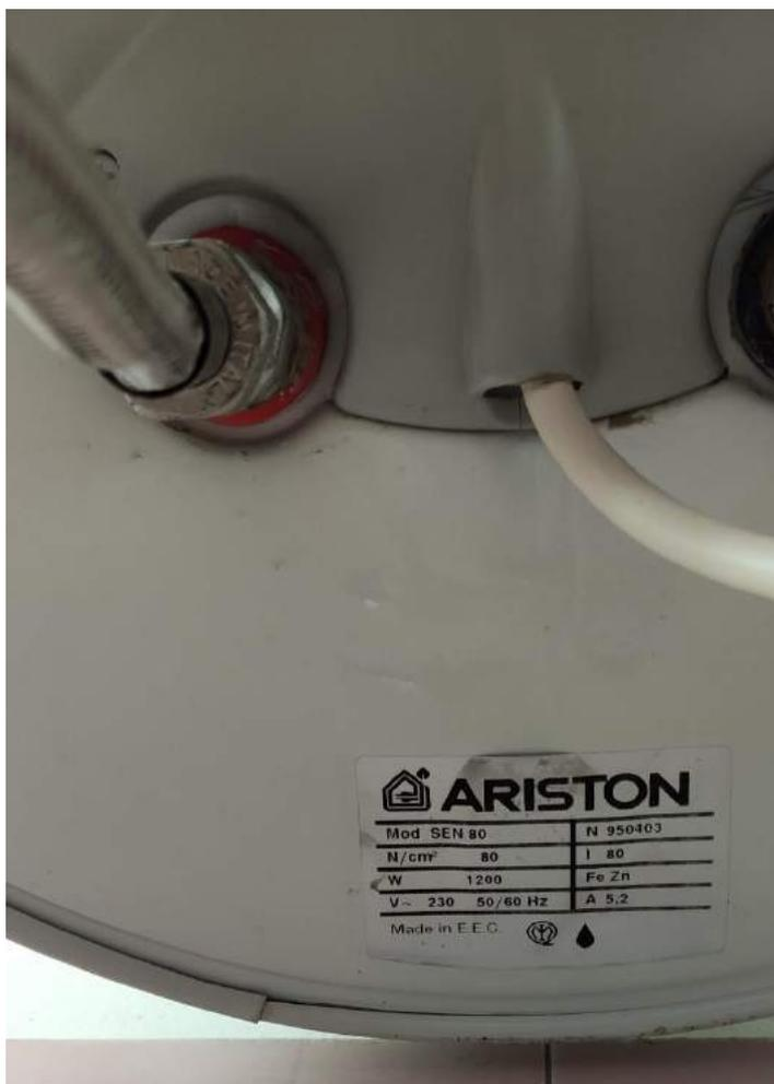
Fig.7: Scaldacqua elettrico Ariston per ACS.
